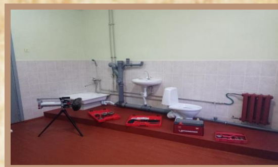
Мастерская санитарно-технических работ
